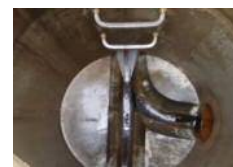
管渠内洗浄中
