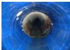
更生工事 (3Sセグメント工法)
