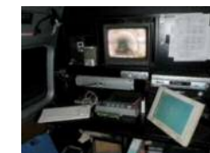
TVカメラ車内部
